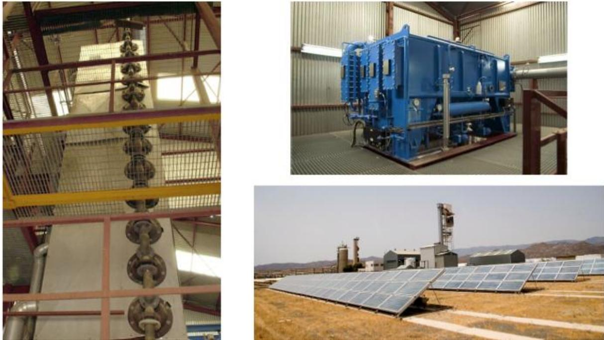
*Fig. 17. Usine SOL-14 MED de PSA (à gauche), pompe à chaleur à absorption de type LiBr-H<sub>2</sub>O (en haut à droite) et champ de capteurs solaires CPC de 500 m<sup>2</sup> (en bas à droite)*
