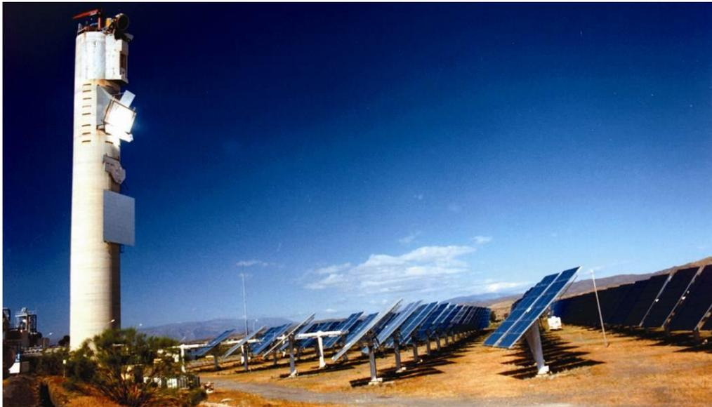
*Fig. 3. L'installation CESA-1 vue de l'est avec des rangées d'héliostats orientés vers le niveau de test de hauteur moyenne (60m)*
