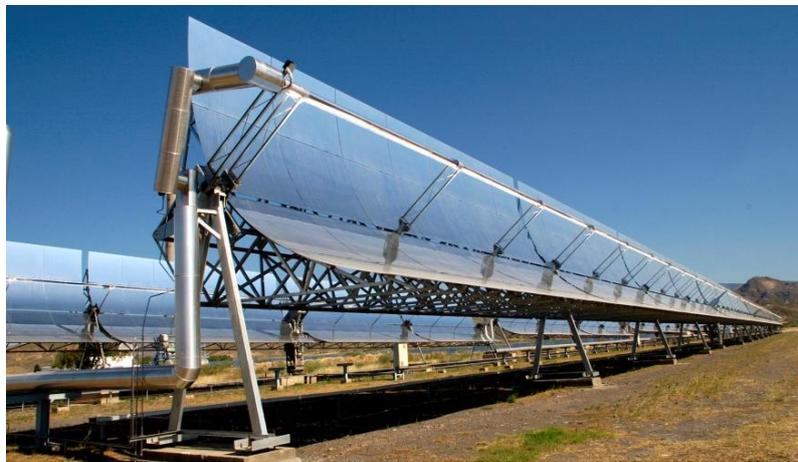
*Fig. 6. Champ de capteurs solaires de la boucle DISS de PSA*
