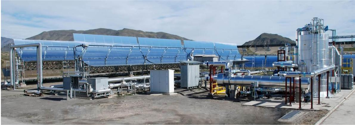
*Fig. 7. Vue de la boucle d'essai à gaz pressurisé reliée à une unité de stockage d'énergie thermique à sels fondus*
